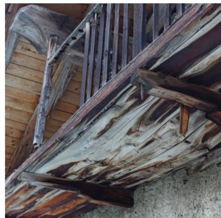
Détail de l'assemblage d'un balcon muni de chevilles.
