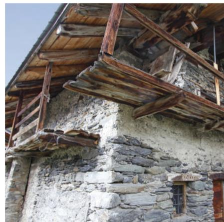
En Haute-Tarentaise, le bois n'est utilisé que pour la charpente, les balcons, voire les linteaux.
