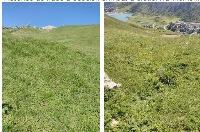
Point particulier n°4 – Zone d'écoulement préférentiel _07/2025 Trace de ravinement probable en période de fonte ; suivi de la tranchée récente d'un réseau sec enterré revégétalisée
