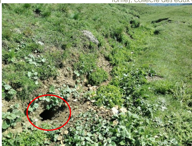
Point particulier n°9 – Renvoi d'eau, fossé végétalisé _07/2025 Terrier de marmotte dans le renvoi d'eau témoignant de l'absence d'écoulement
