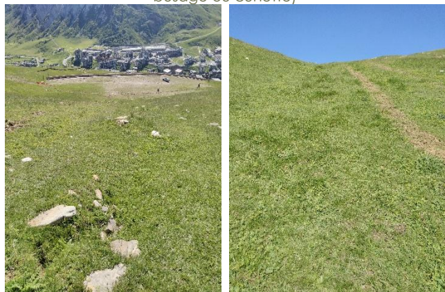
Point particulier n°3 – Zone d'écoulement préférentiel _07/2025 Trace de ravinement probable en période de fonte ; suivi de la tranchée récente d'un réseau sec enterré revégétalisée
