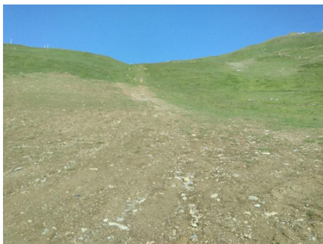
Point particulier n°1 – Fin d'écoulement _07/2025 Vue vers le haut ; Secteur avec terrassement récent Pas de trace d'écoulement préférentiel
