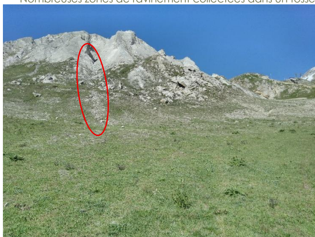
Point particulier n°11 – Vue d'ensemble de « l'impluvium » _07/2025
