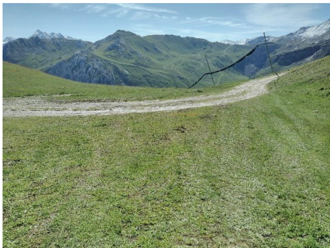
Point particulier n°8 – Traversée de piste tout-terrain _07/2025 Vue vers le bas
