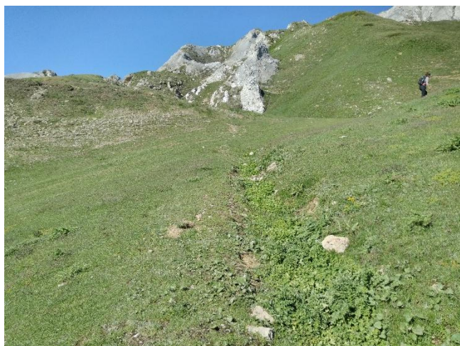
Point particulier n°9 – Renvoi d'eau, fossé végétalisé _07/2025 Vue vers le haut Fossé, renvoi d'eau (protection contre l'érosion en période de fonte)
