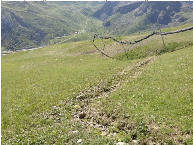
Point particulier n°6 – Renvoi d'eau _07/2025
