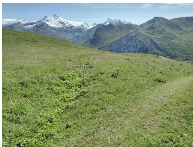
Point particulier n°10 – Renvoi d'eau, fossé végétalisé _07/2025 Vue vers le bas Fossé, renvoi d'eau (protection contre l'érosion en période de fonte) avec exutoire dans l'entonnoir à gypse vers le nord
