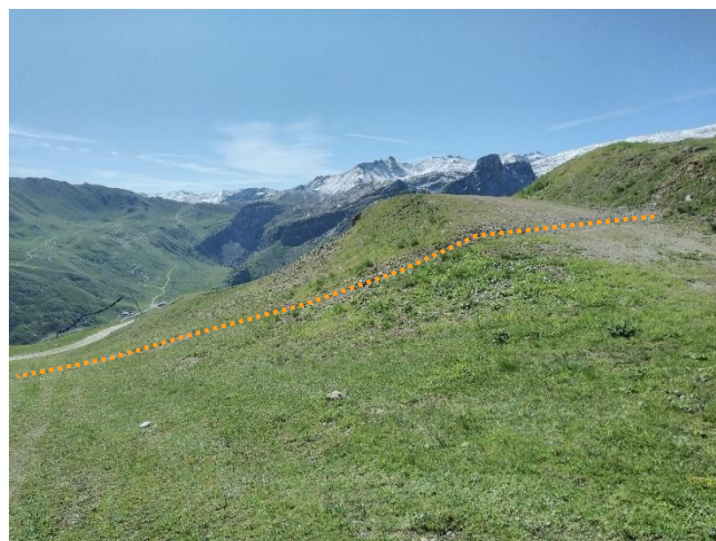
Point particulier n°9 – Renvoi d'eau, fossé végétalisé _07/2025 Vue vers le haut Fossé, renvoi d'eau (protection contre l'érosion en période de fonte), collecte des eaux de ruissellement de la piste amont
