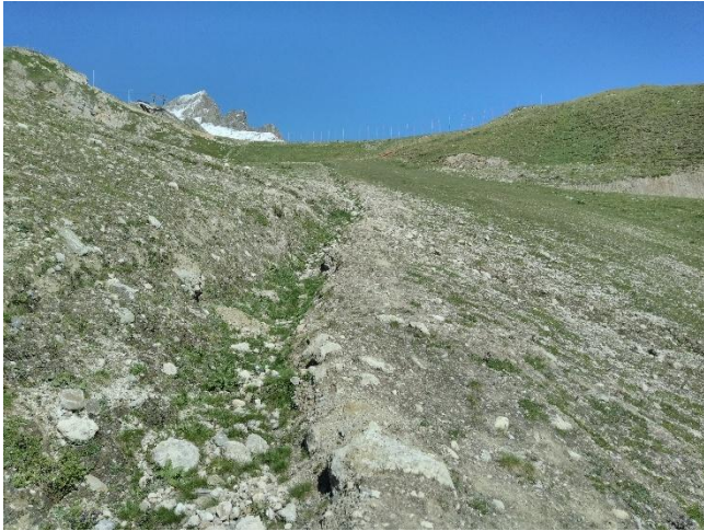
Point particulier n°12 – Fossé de collecte _07/2025 Renvoi d'eau et fossé de collecte en période de fonte
