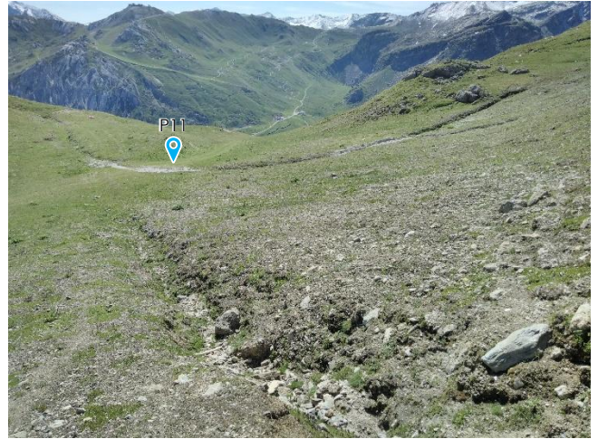
Point particulier n°12 – Fossé de collecte _07/2025 Renvoi d'eau et fossé de collecte en période de fonte, exutoire vers fossé point particulier n°11
