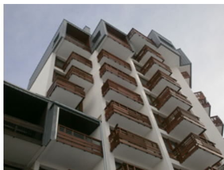
Rénovation au Curling, CAUE, 2015
