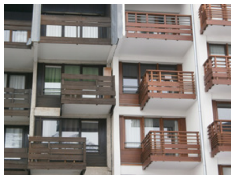
Rénovation au Curling, CAUE, 2015
