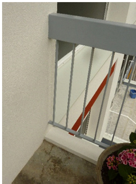
La profondeur des balcons, un élément déterminant dans le choix de l'épaisseur de l'isolant, ASDER, 2015
