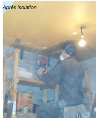
Exemple de mise en œuvre d'isolation par plaque dans des caves, ASDER, 2015
