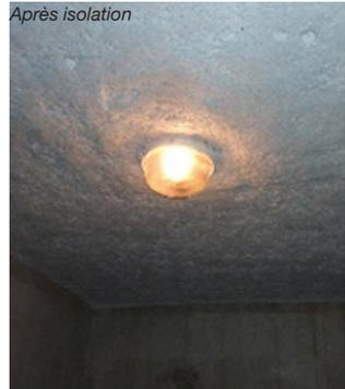
Exemple de mise en œuvre d'isolation projetée dans des caves, ASDER, 2015
