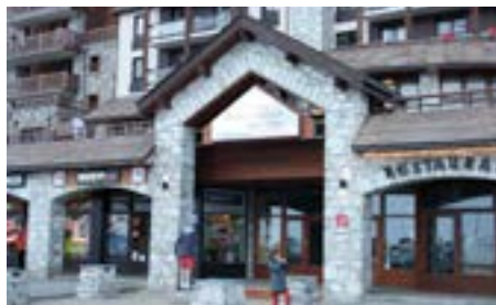
Soubassement en pierres au Diva, CAUE, 2015
