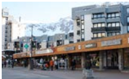
Linéaire commercial, CAUE, 2015
