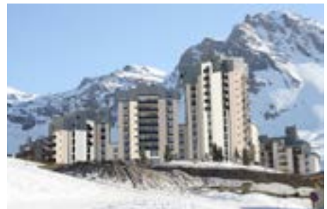
Teintes marquant les travées, L.Louis, CAUE, 2015
