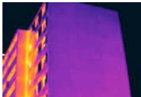
Façade avec isolation, Asder, 2015
