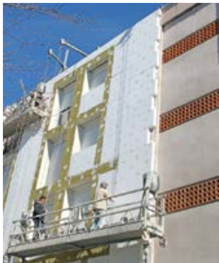
Isolation par l'extérieur d'une façade, Fotolia, 2015
