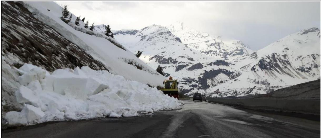
**Photo 6. Avalanche de type à la fois « plaque de fond » et « coulée de talus », partie en aval des râteliers et arrivant sur la RD 87A, juste en amont de l'emplacement prévu pour le parking en projet. Photo TDL Savoie le 8 avril 2018.**
