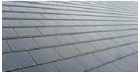
Tuiles solaires, ASDER, 2015
