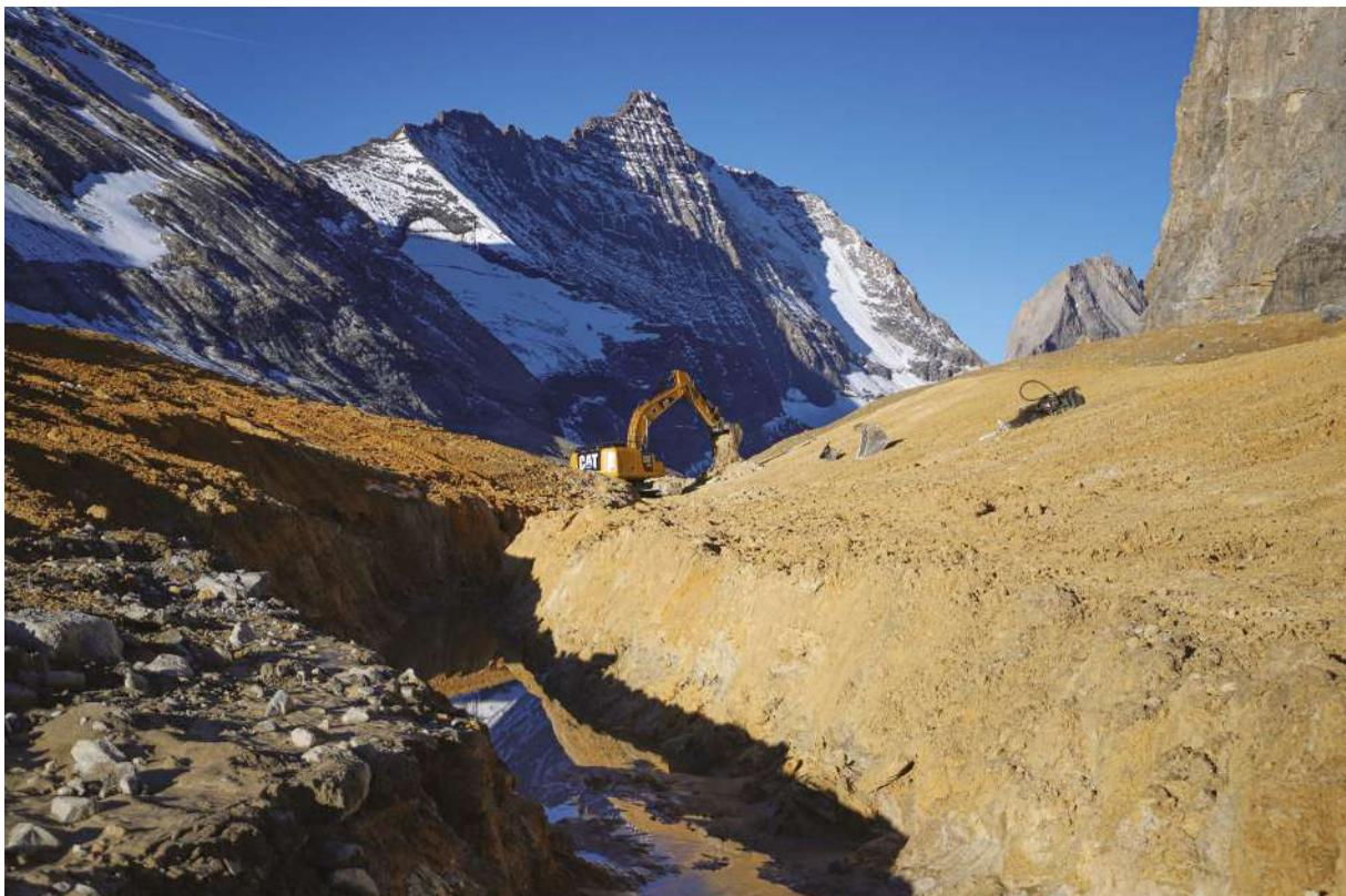
Creusement du chenal (profondeur de -6m) à l'aval du lac et remise en forme des matériaux.
