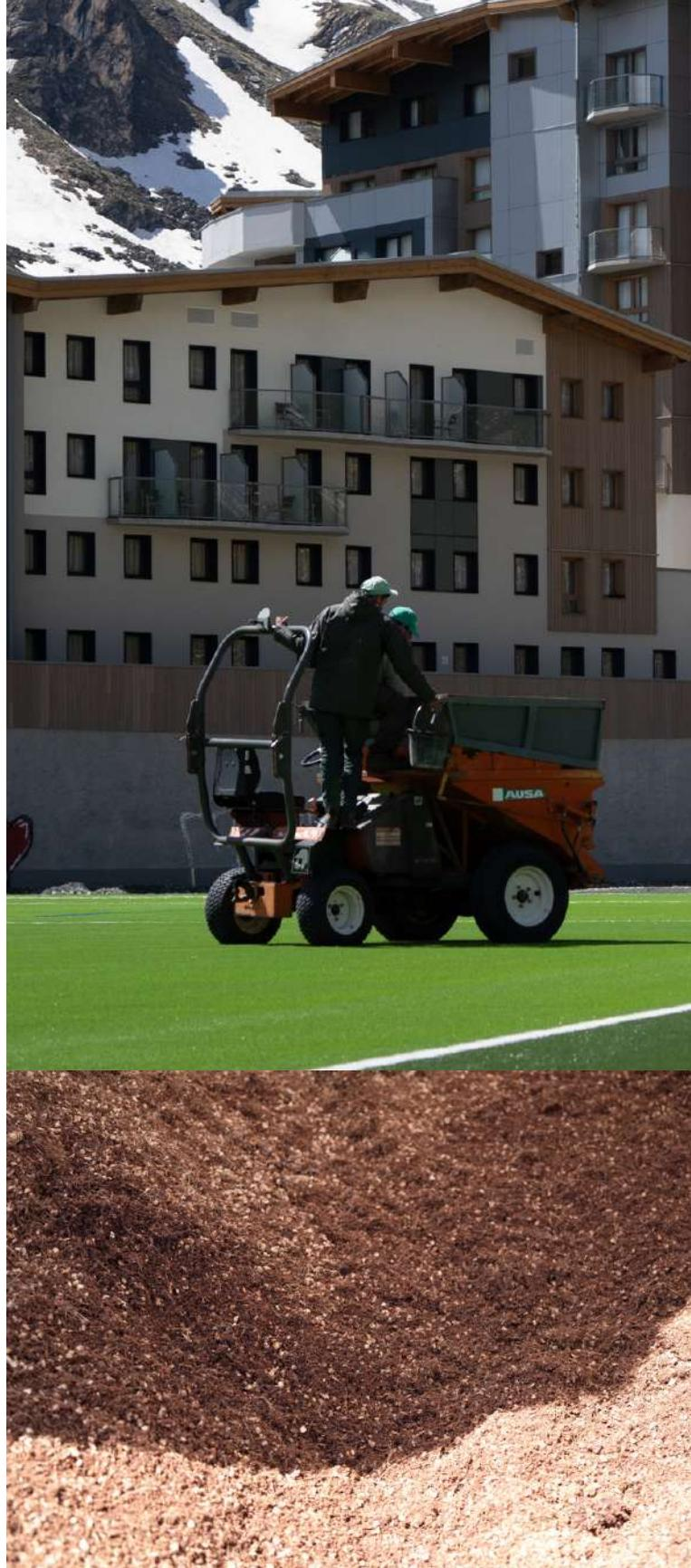
Le mélange - noix de coco / liège - utilisé pour la surface du terrain synthétique
