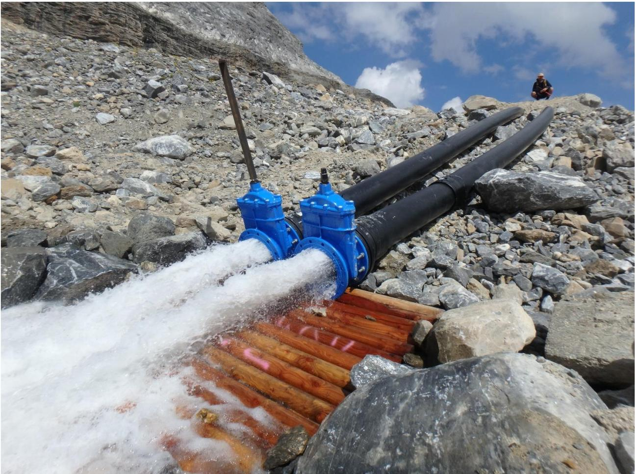
*Figure 2 : Le dispositif de siphonnage en service© ONF-RTM*
